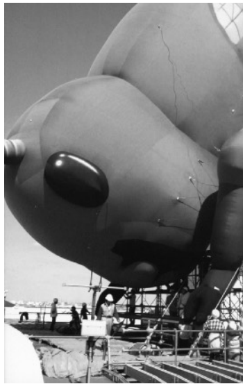
巨大バッタ、設置風景
